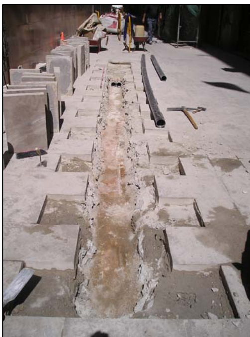
F.3: Vista general de la rasa al Ptge.d'Escudellers on s'aprecia la solera de la claveguera 1006.
