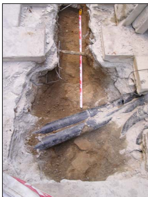
F.2: Vista del sondeig davant el número 6-10 del Ptge.d'Escudellers on s'aprecien els tubs de PVC 1004 i la solera de la claveguera 1006.
