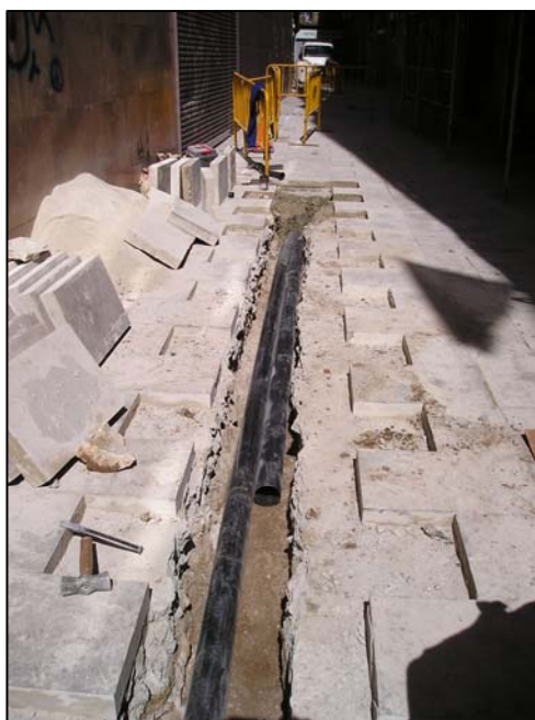
F.4: Vista general de la rasa al Ptge.d'Escudellers un cop instal·lats els tubs de Telefònica.
